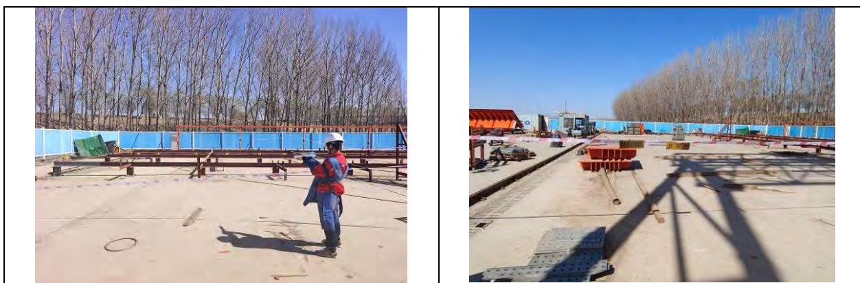
图 6-1 模拟现场探伤照片（拍摄于 2024 年 3 月）
