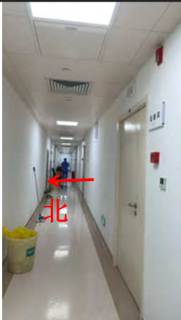
02 手术间北侧污物走廊
