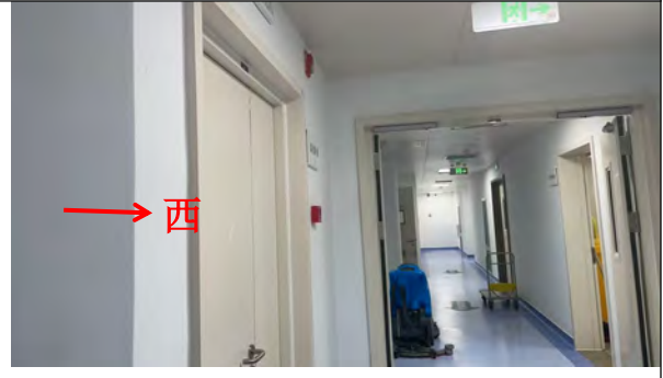
06 手术间东侧设备间及污物走廊
