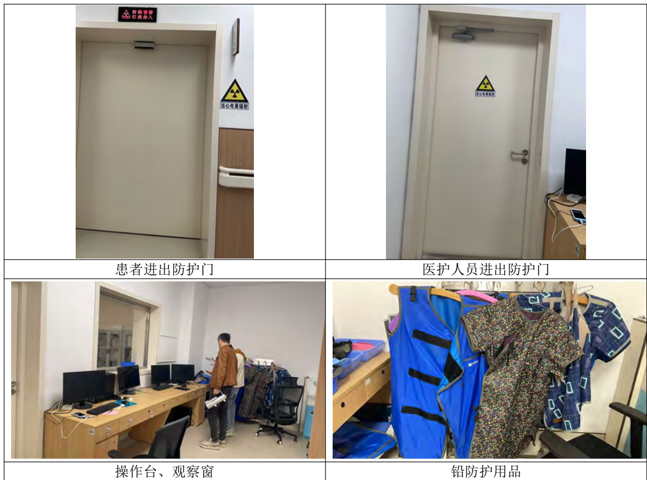
图 3-2 内镜中心 ERCP 手术室辐射安全与防护措施现场照片（2025 年 4 月）
