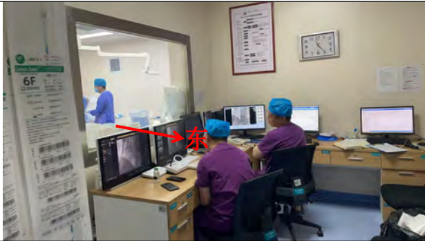
03 手术间东侧控制室 (04 手术间西侧)
